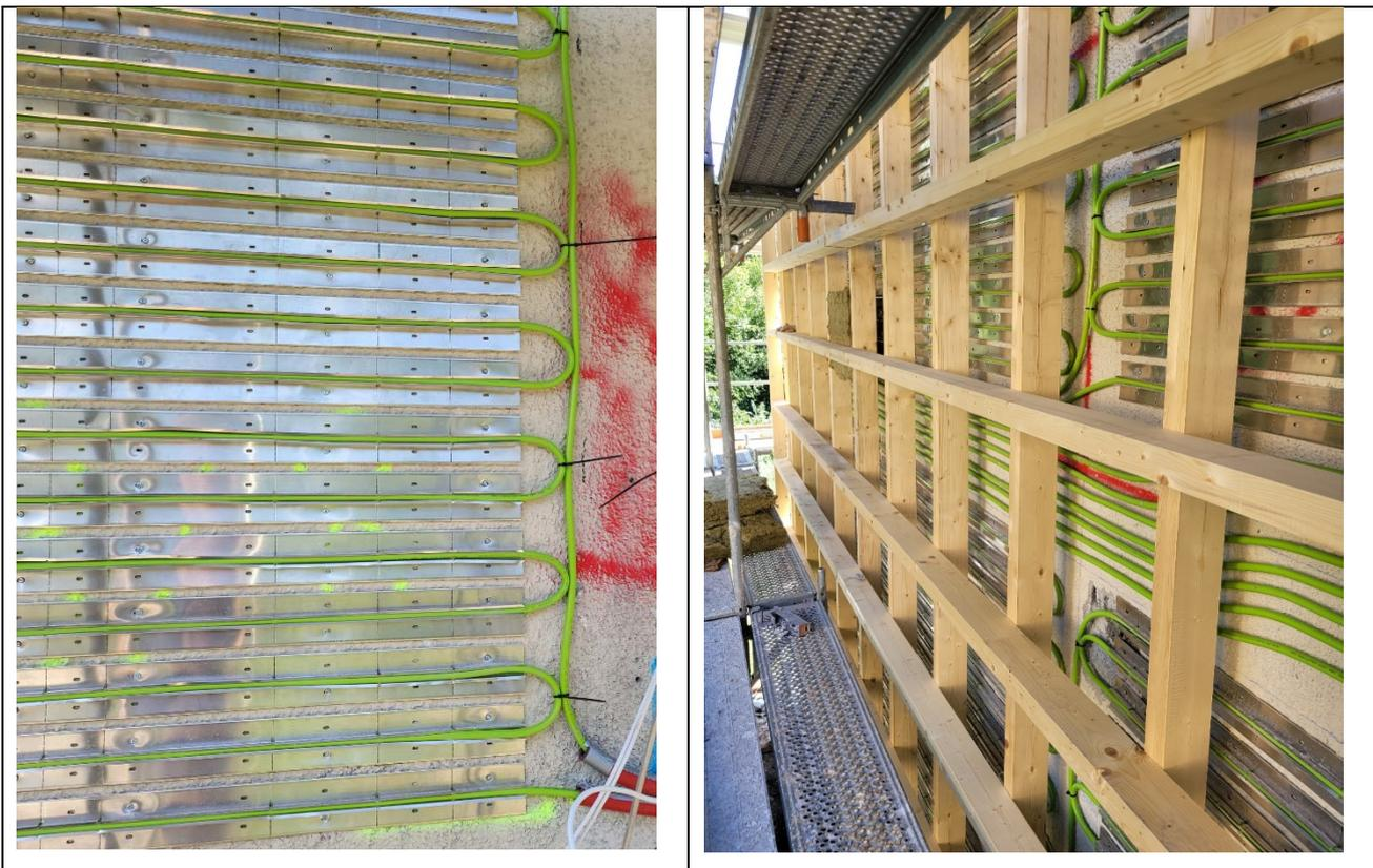
**Abbildung 2: Nachträglich installierte Bauteilaktivierung der Außenwand. Links: Heizschlangen mit Wärmeleitblechen (System CEPA) Rechts: Kreuzlagen in Holzbauweise, welche mit Dämmstoff gefüllt werden. Quelle: Energieinstitut Vorarlberg.**
